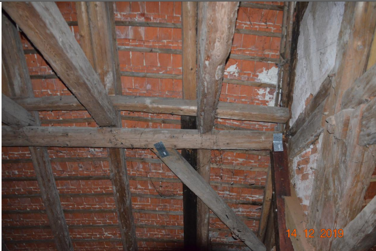
Widoczne ugięcie płatwi P2
