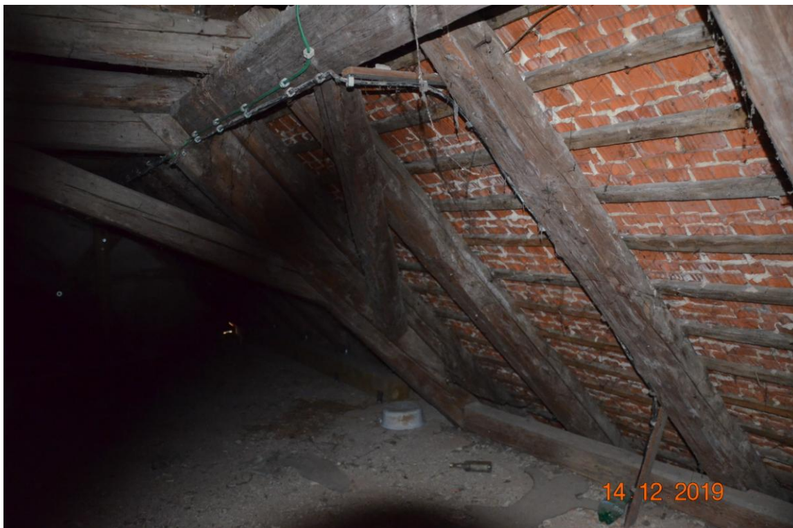
Widoczne ugięcie płatwi P2
