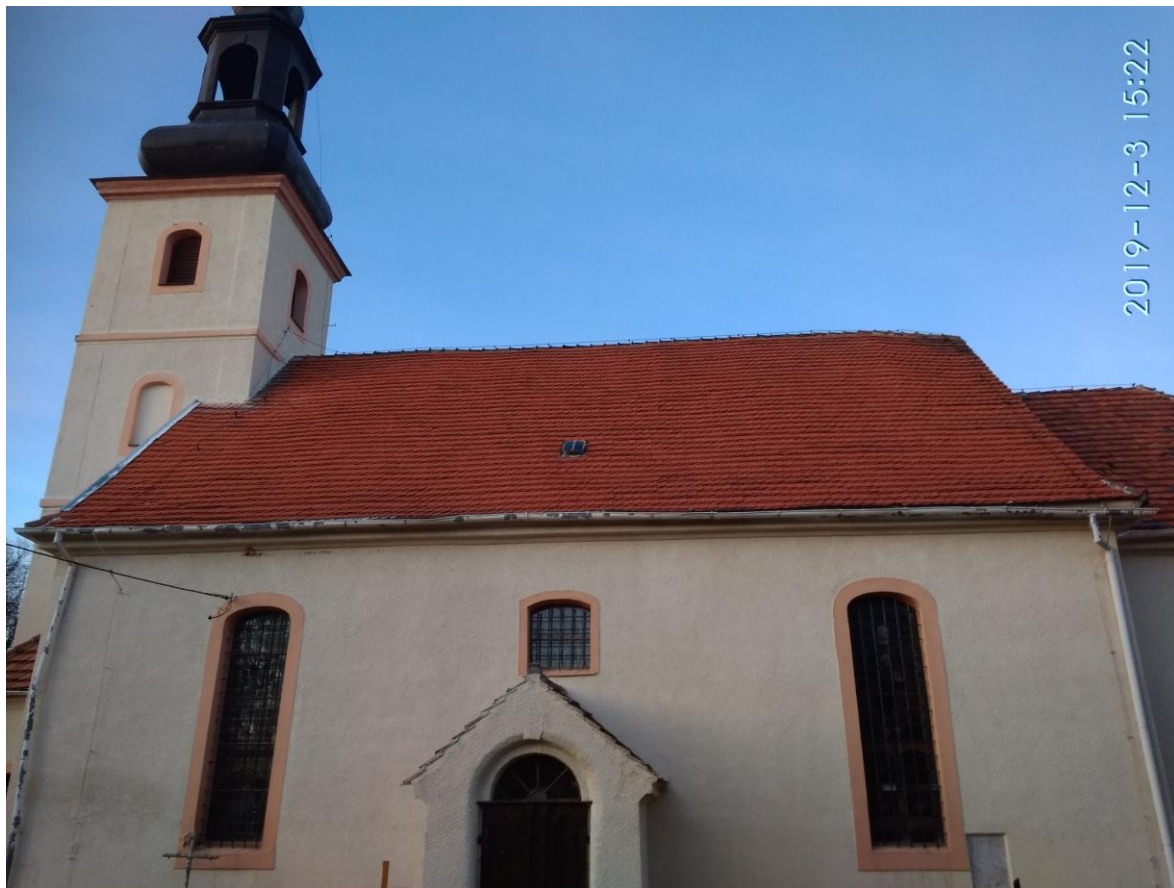
Widoczne ugięcie więźby dachowej po prawej stronie dachu
